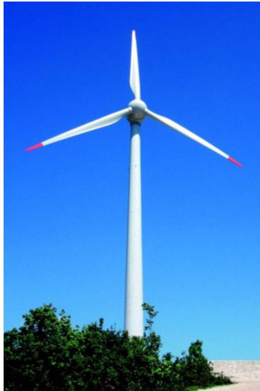
Slika 80. Končar vjetroagregat K80, nazivne snage 2,5 MW
