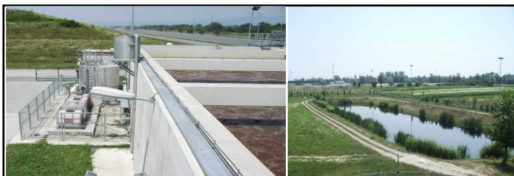
Slika 9. Uređaji za pročišćavanje vode
