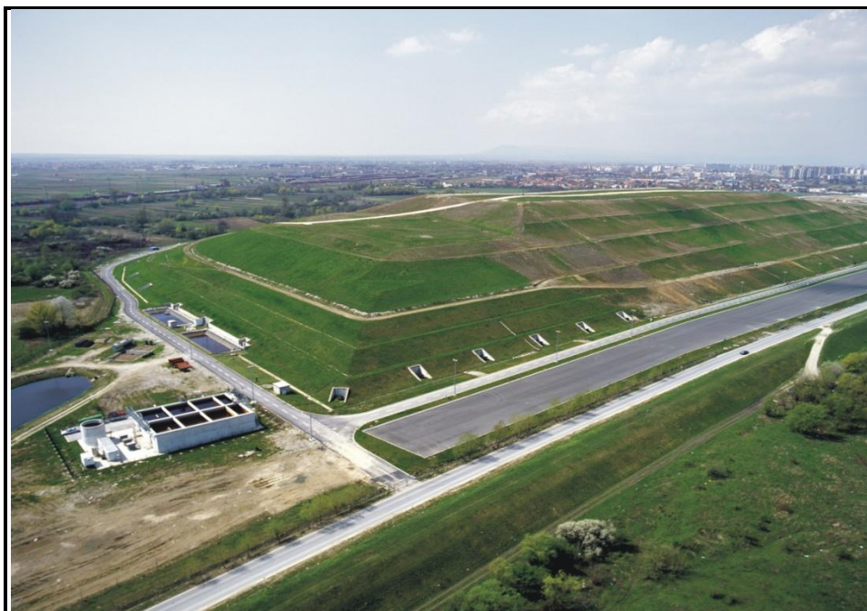
Slika 12. Izgled Odlagališta otpada Prudinec Jakuševac
