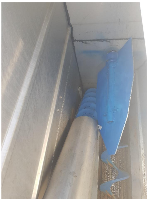
Slika 21. Filter teške frakcije (pjeskolov) [29]
