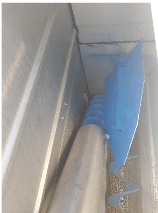
Slika 21. Filter teške frakcije (pjeskolov) [29]
