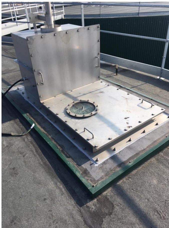
Slika 27. Kontrolno okno integrirano u nosač miješalice [29]
