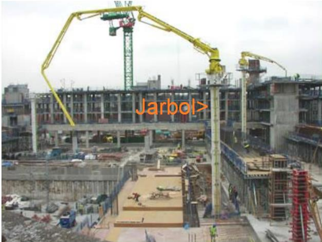
Slika 3. Cijevni jarbol za transport betona [8]
