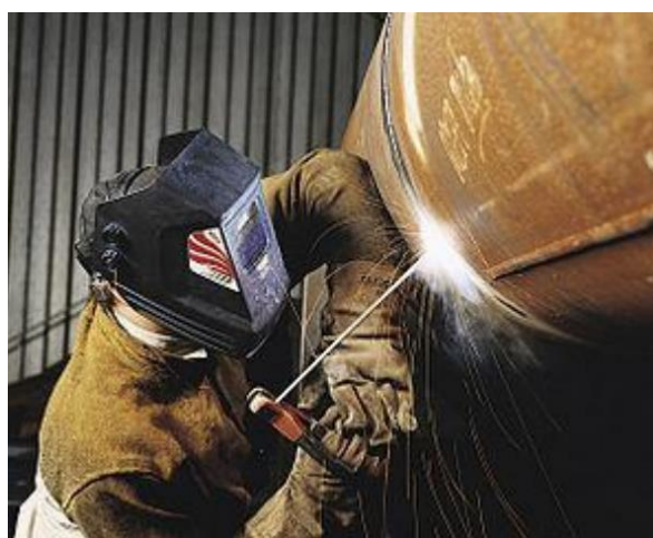
Slika 43. REL postupak zavarivanja [22]
