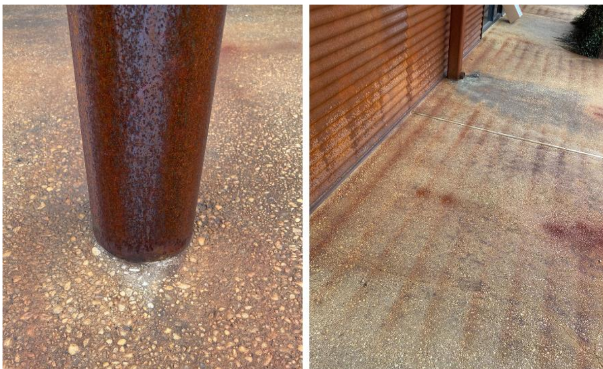
Slika 11. Posljedice ljuštenja oksidnog sloja Corten čelika [26]
