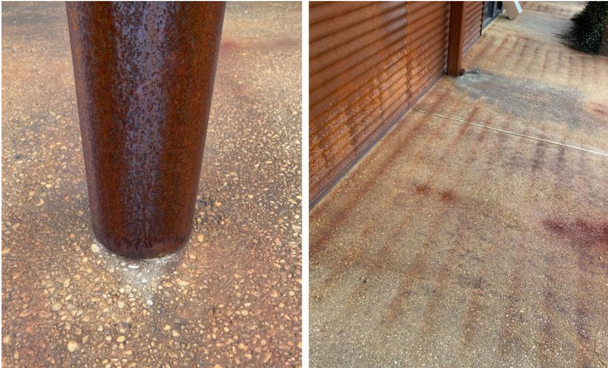
Slika 11. Posljedice ljuštenja oksidnog sloja Corten čelika [26]
