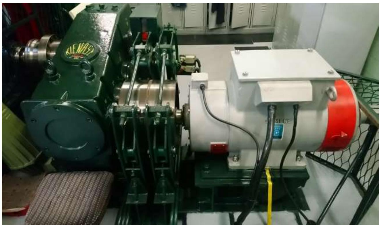
Slika 21 Elektromotor i reduktor za pogon uspinjače - slika sa servisa 25.10.2021.
