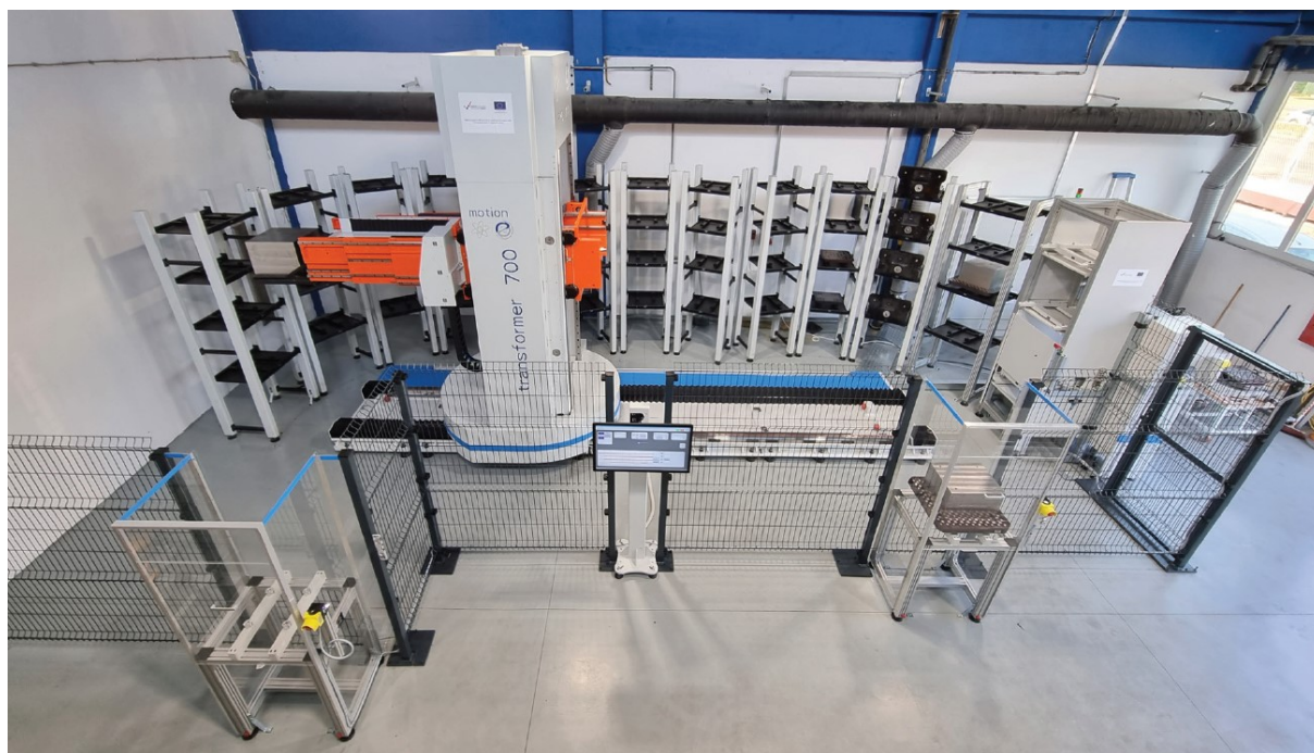
Slika 14. Prikaz postavljenog hibridnog uređaja, regalnog skladišta paleta i automatizirane stanice za punjenje [9]
