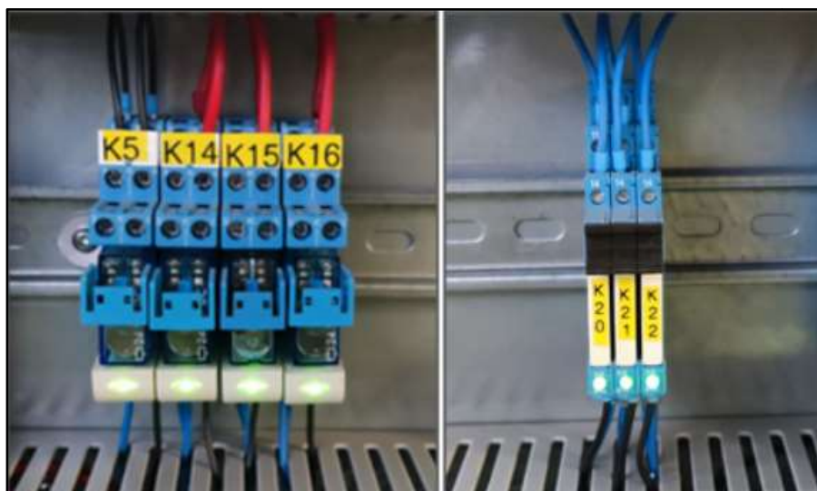
Slika 25. Uključivanje vodenog i zračnog hlađenja
