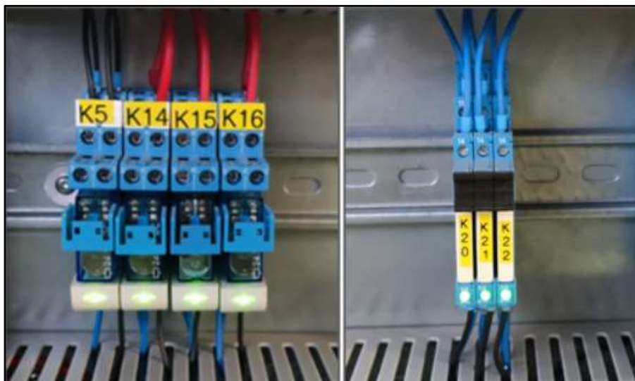
Slika 25. Uključivanje vodenog i zračnog hlađenja
