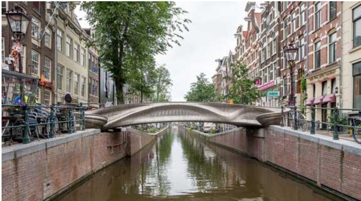
Slika 22. Most od nehrđajućeg čelika proizveden WAAM postupkom [27]
