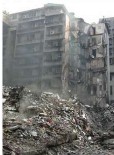
(b) Južno pročelje
