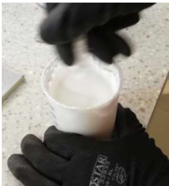
Slika 24. Razrjeđivanje i miješanje PROMAPAIN-T-SC 4 vodorazrjedivog premaza prije aplikacije
