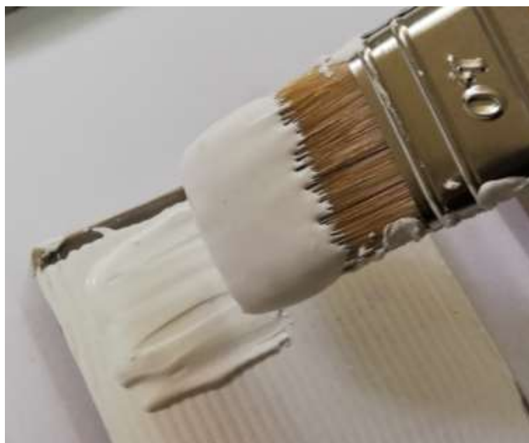
Slika 28. Tehnika nanošenja premaza kistom
