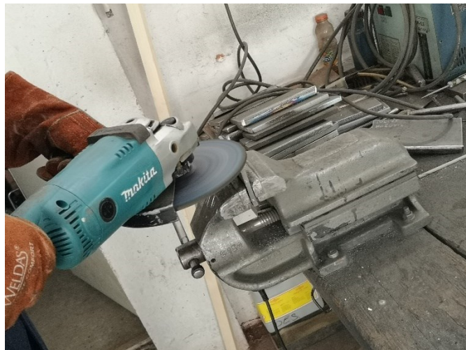
Slika 48. Priprema zida za zavarivanje
