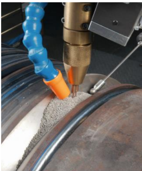
Slika 7. Zavarivanje pod zaštitom praška [18]
