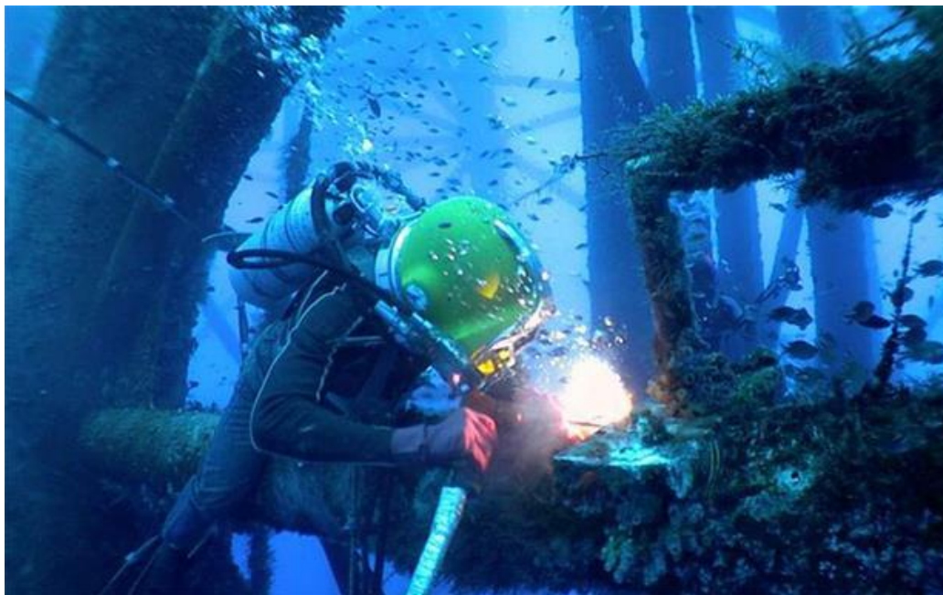
Slika 23. Reparacija nosača platforme [26]
