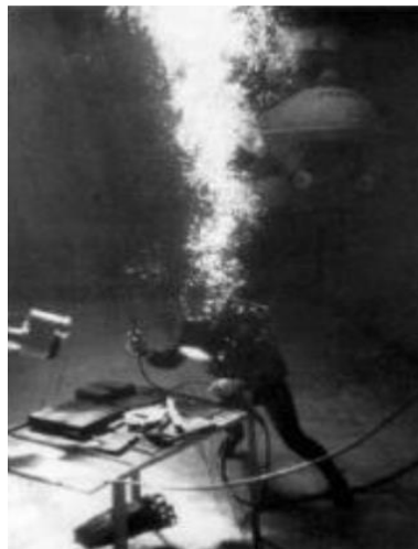
Slika 1. Prve izvedbe zavarivanja pod vodom [2]
