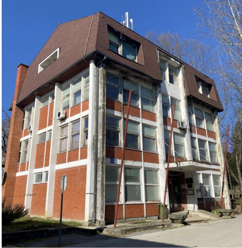
Slika 1. Postojeće stanje zgrade
