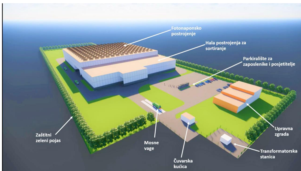
Slika 16. Automatska sortirnica otpada – Grad Zagreb [15]
