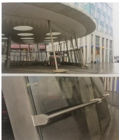
Slika 6. Primjena dupleks nehrđajućeg čelika u građevinarstvu [3]
