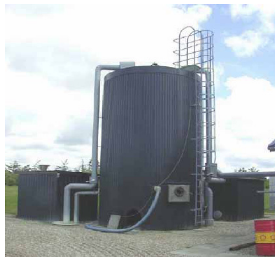
Slika 2.33. Spremnik za odvajanje sumporovodika
