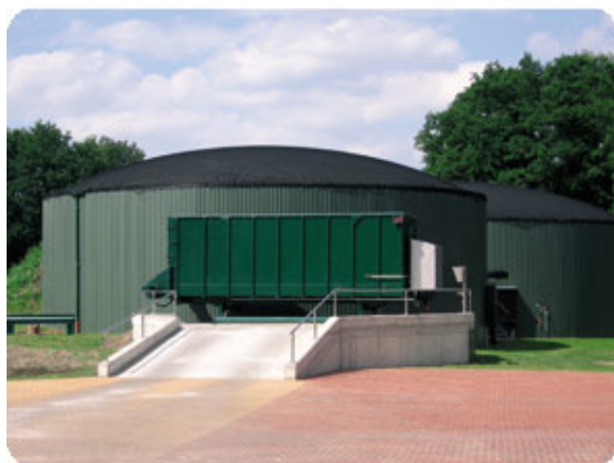
Slika 2.36. Spremnik digestata prekriven membranom
