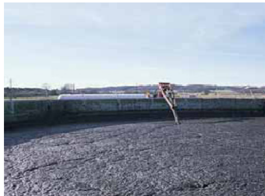
Slika 2.35. Spremnik za skladištenje digestata
