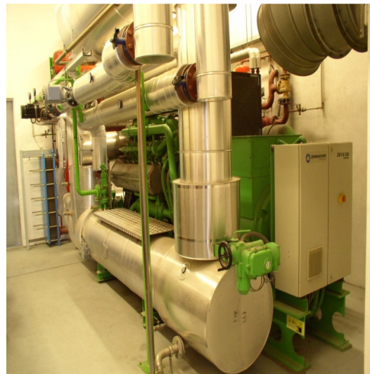
Slika 2.15. Kogeneracijska jedinica
