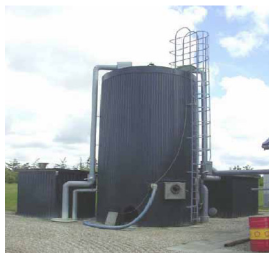
Slika 2.33. Spremnik za odvajanje sumporovodika
