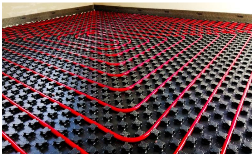
Slika 3.4. Ugradnja serpentine petlje na rešetkastu podlogu [9]
