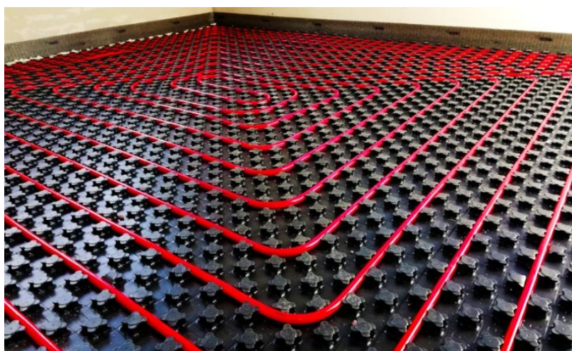
Slika 3.4. Ugradnja serpentske petlje na rešetkastu podlogu [9]
