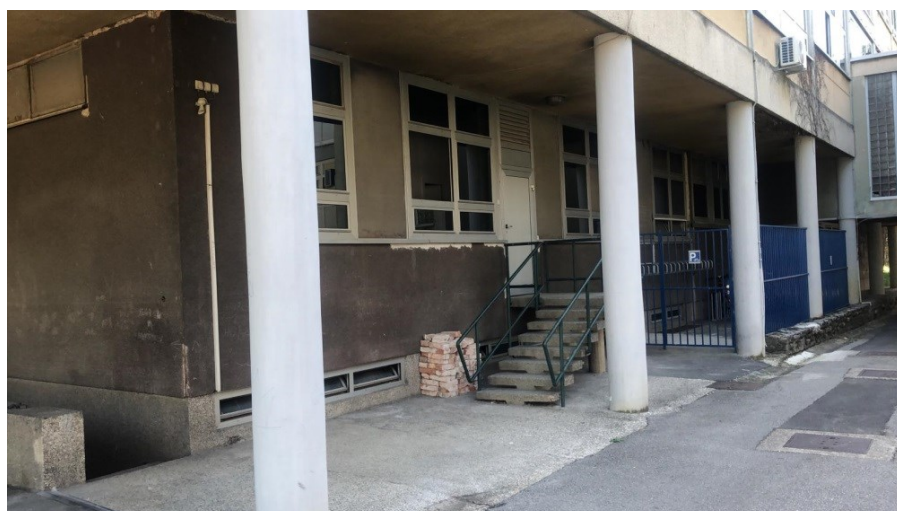
Slika 12. Postojeće stanje sjevero-istočnog pročelja niskog prizemlja
