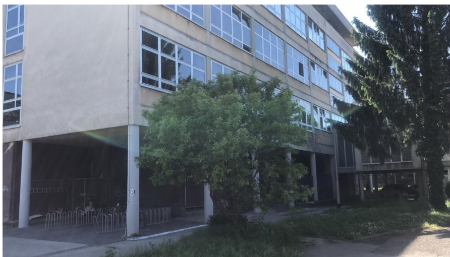
Slika 11. Postojeće stanje sjevero-istočnog pročelja visokog prizemlja
