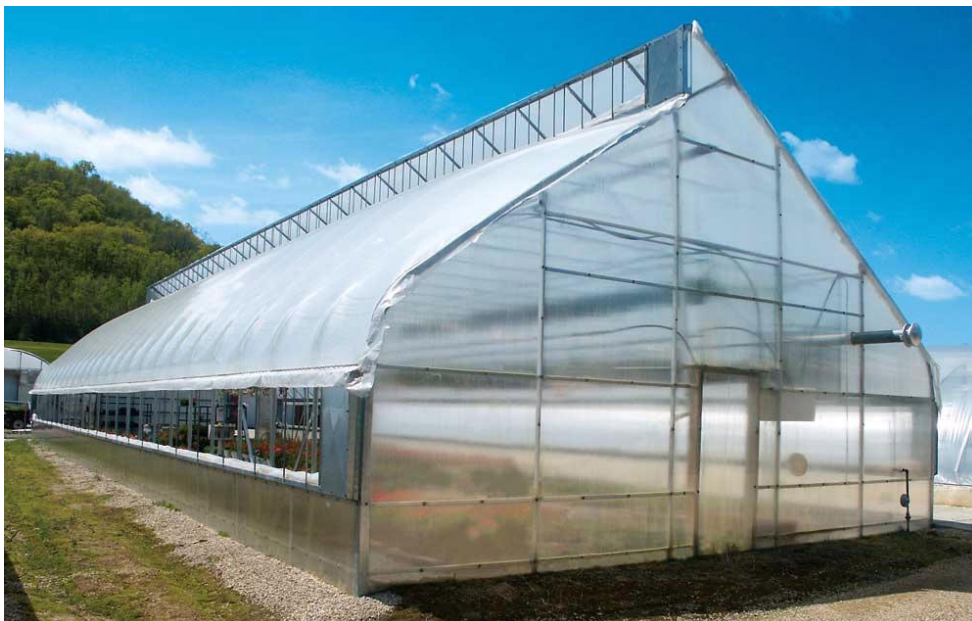
Slika 2. Sustav za prirodnu ventilaciju [3]
