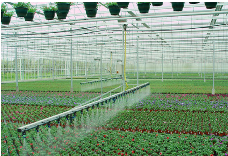
Slika 2.4. Boom navodnjavanje
