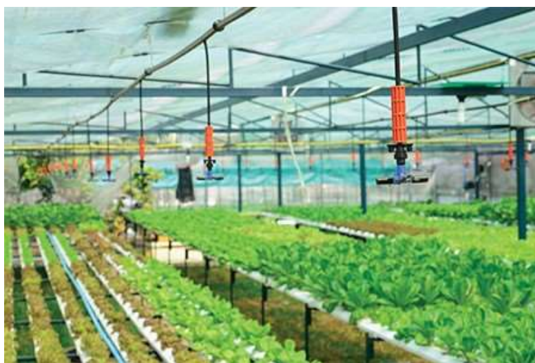
Slika 2.3. Navodnjavanje prskalicama
