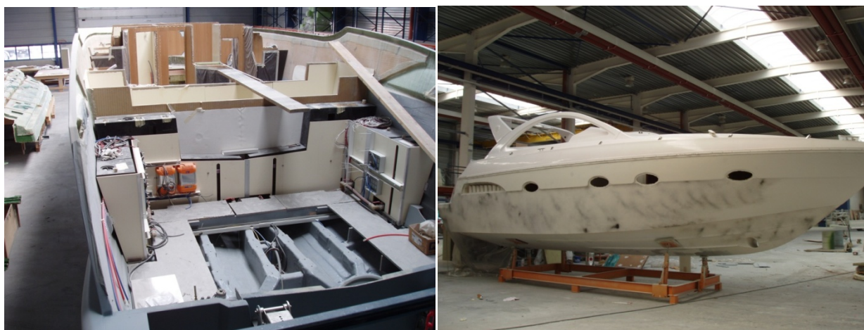
Slika 5.17. Prikaz ugradnje električnih i drugih instalacija u trup broda, te prikaz gotovog proizvoda [14]
