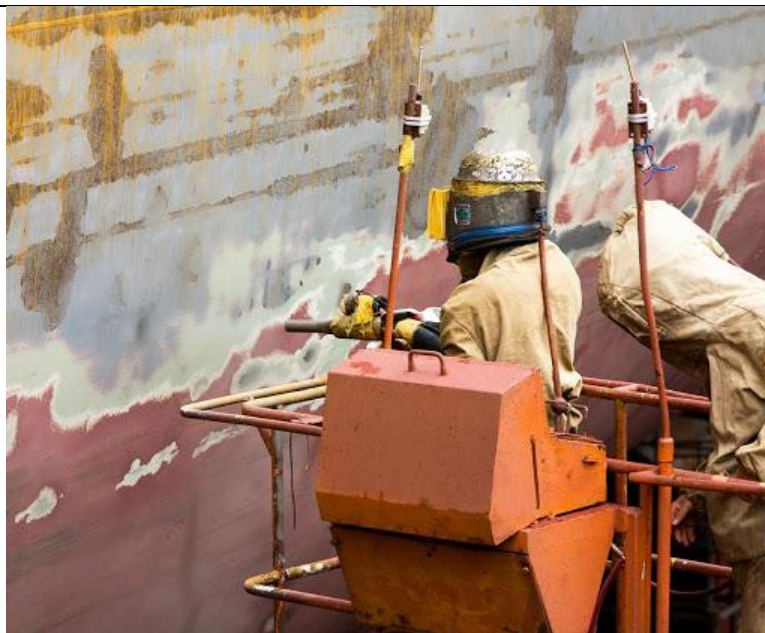
Slika 3. Ručno sačmarenje u brodograđevnoj industriji[12]
