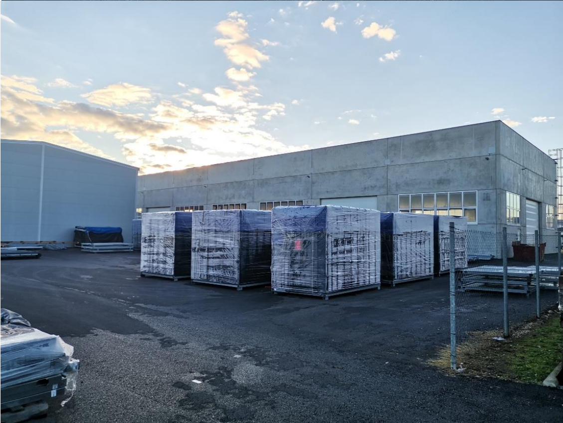
Slika 2. Proizvodne hale tvrtke B&O Prelog d.o.o. : veća hala desno, a manja lijevo
