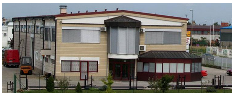
Slika 57. Zgrada poduzeća OMV-INDOIL u Donjem Stupniku [34]
