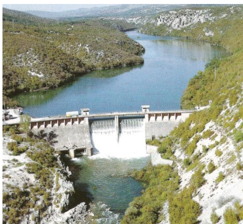
Slika 2 - Pogled na branu Prančevići i akumulacijsko jezero Prančevići
