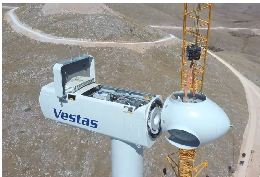
Slika 2.6. Montaža glave rotora na gondolu [8]
