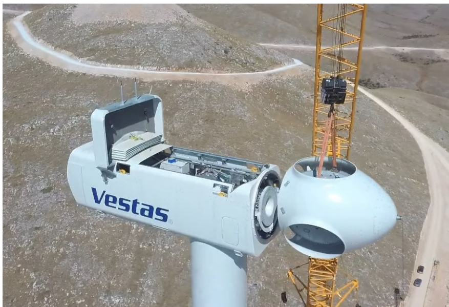
Slika 2.6. Montaža glave rotora na gondolu [8]
