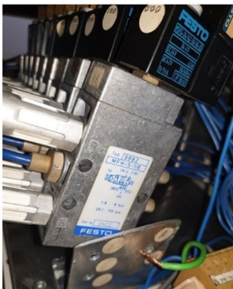
Slika 7. Blok MFH-5-1/8 ventila
