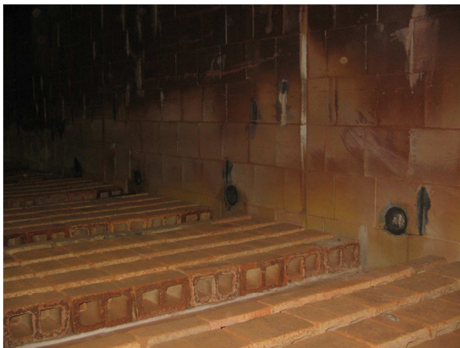
Slika 63. Izbušeni bočni zid peći za prihvat plamenika
