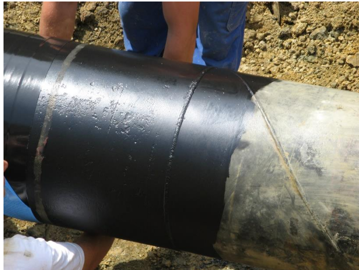
Slika 9.15 Postavljanje izolacijske trake [33]
