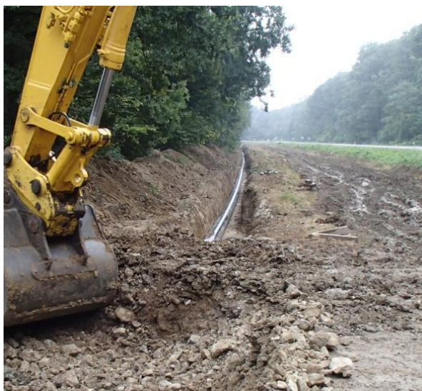
Slika 9.5 Iskop rova [33]
