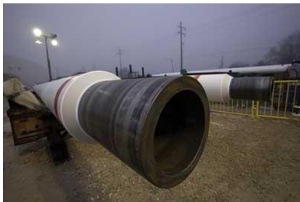
Slika 4.8 Kraj cijevi otežane betonskim prstenom [68]
