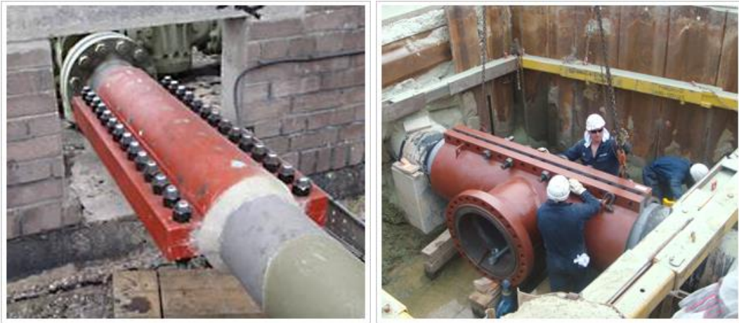
Slika 7.14 Primjeri ugradnje ESR obujmice [59]
