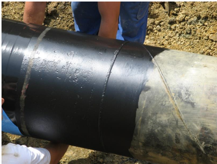
Slika 9.15 Postavljanje izolacijske trake [33]
