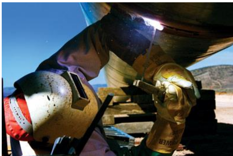
Slika 7.4 Zavarivanje cjevovoda [45]
