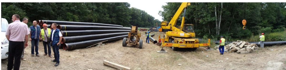
Slika 9.8 Priprema za ugradnju [33]
