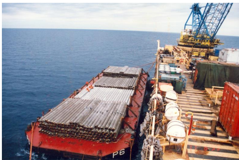
Slika 4.20 Deponija cijevi na barži za plinovod Platforma Ivana A – Platforma Garibaldi K [35]
