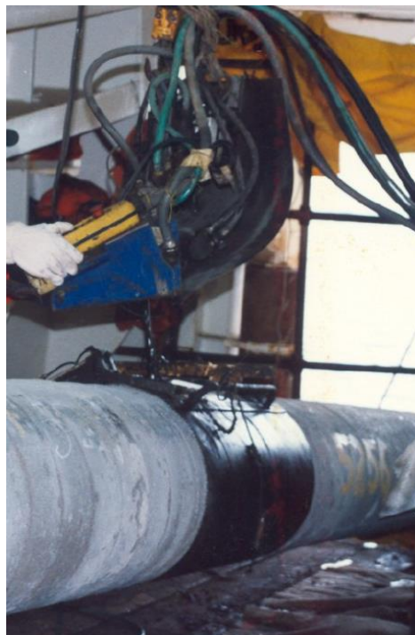
Slika 4.14 Ulijevanje poliuretanske smole u prostor gdje je zavareni spoj [35]
