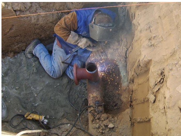
Slika 7.10 Održavanje zavarivanjem [33]
