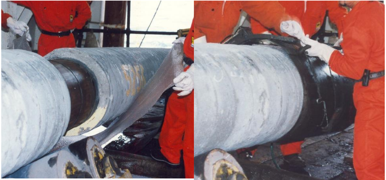
Slika 4.13 Postavljanje plastičnog ovala i kalupa oko mjesta zavarenog spoja [35]
