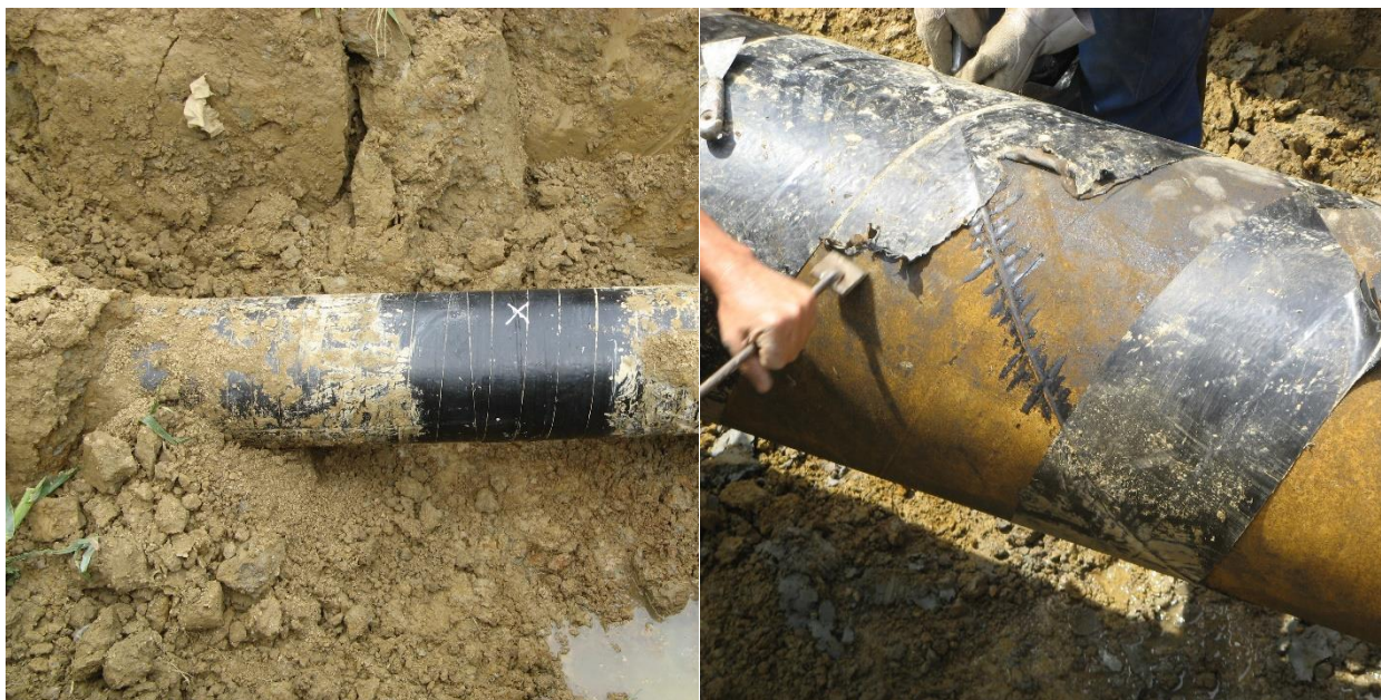
Slika 9.14 Iskopano mjesto oštećenja i skidanje izolacije [33]
