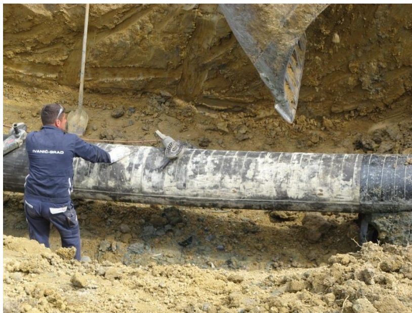
Slika 9.11 Skidanje izolacije i čišćenje cijevi [33]
