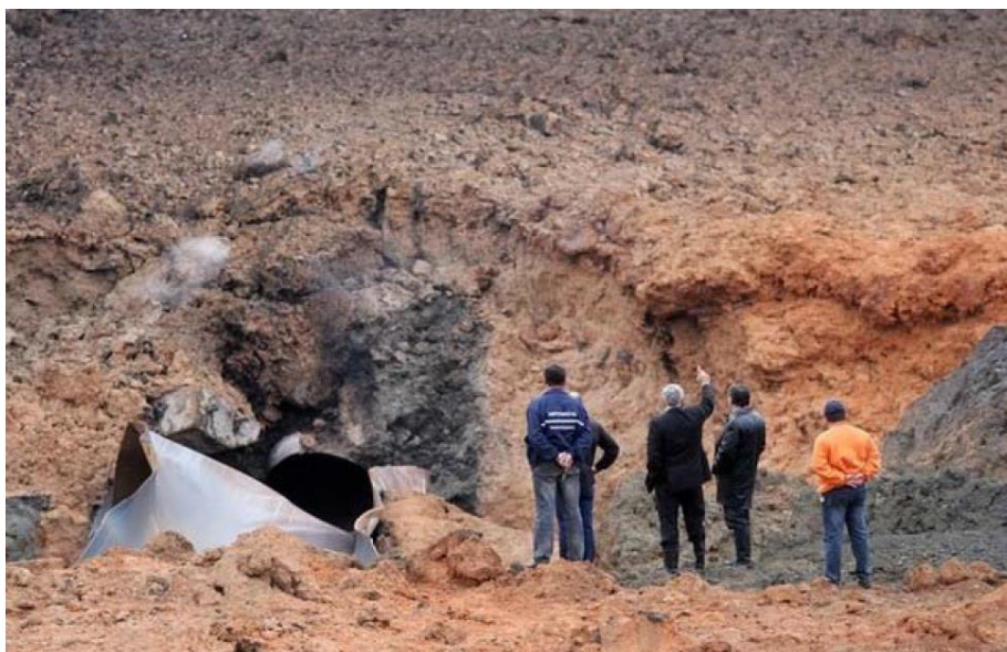
Slika 5.1 Eksplozija plinovoda Ukrajina - svibanj 2007. [63]
