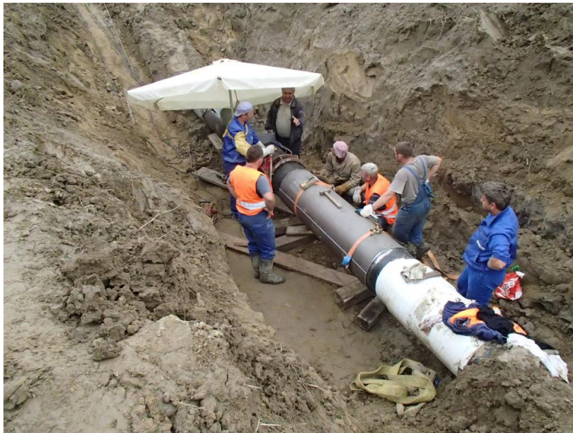
Slika 7.11 Primjer ugradnje čelične obujmice [33]
