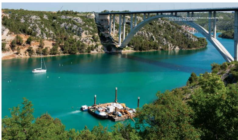
Slika 3.6 Polaganje plinovoda Benkovac – Dugopolje na dno rijeke Krke kod Skradina [33]
