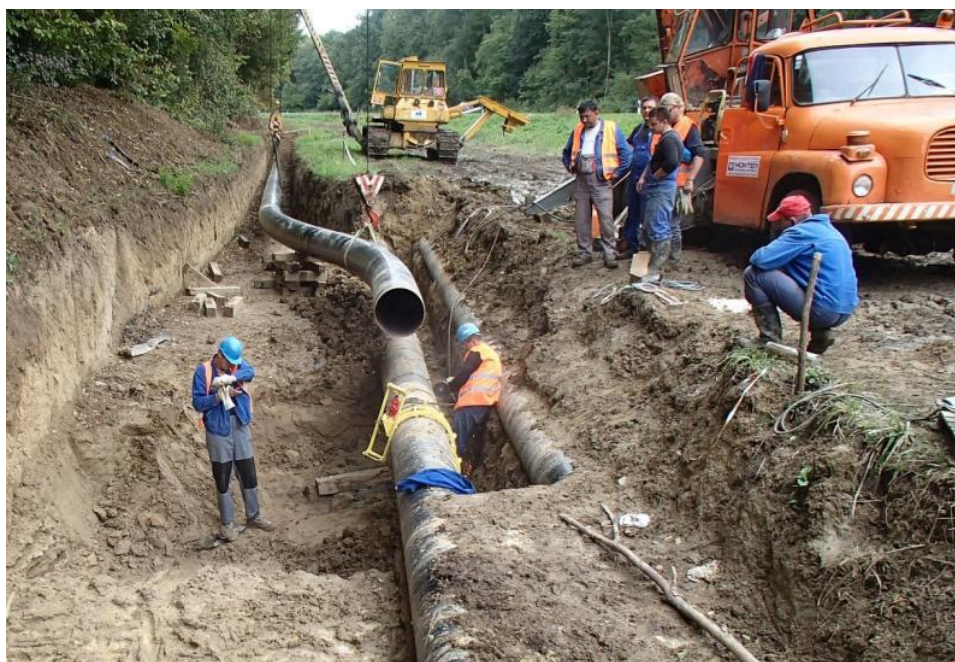
Slika 9.10 Polaganje cijevi [33]
