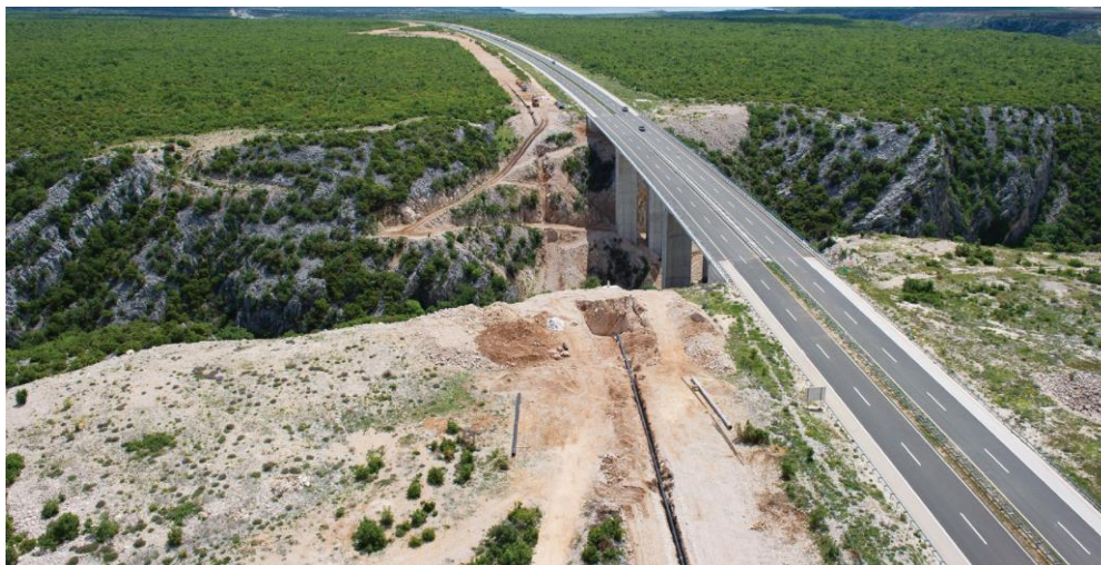
Slika 1.1 Izgradnja plinovoda Benkovac – Dugopolje – kanjon Guduča [33]
