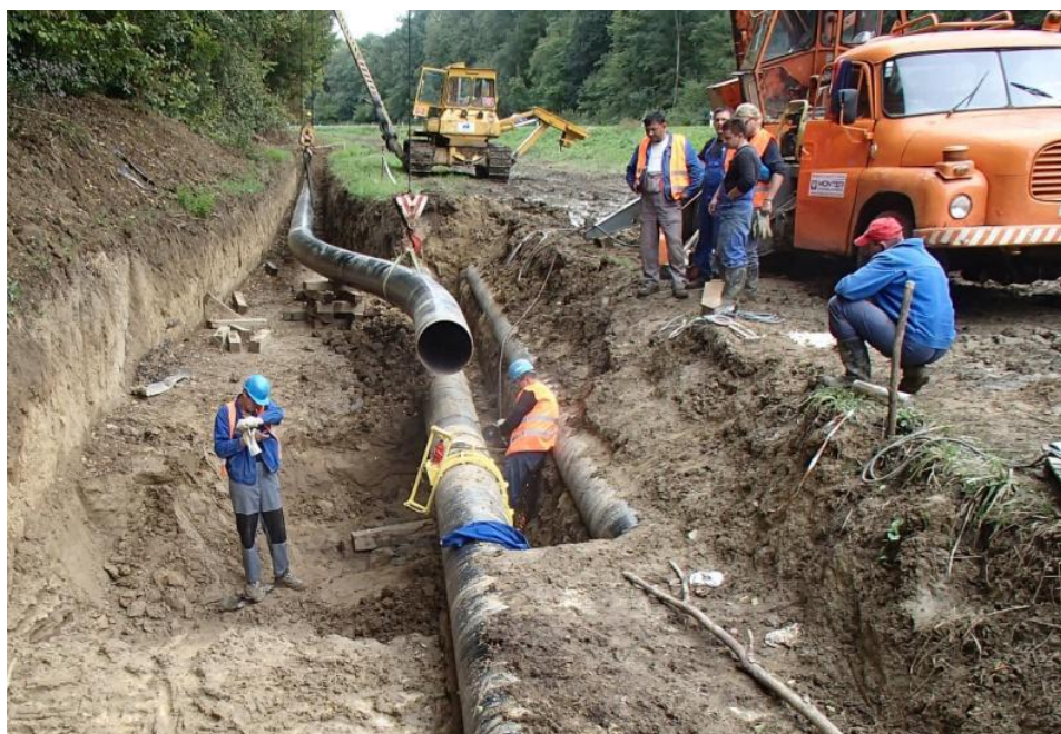
Slika 9.10 Polaganje cijevi [33]
