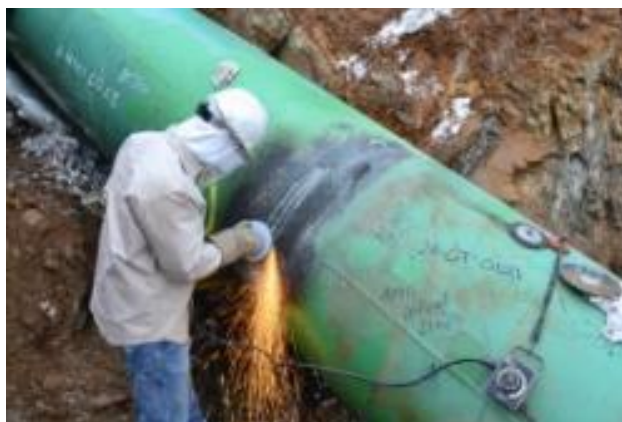
Slika 7.3 Popravci brušenjem [45]
