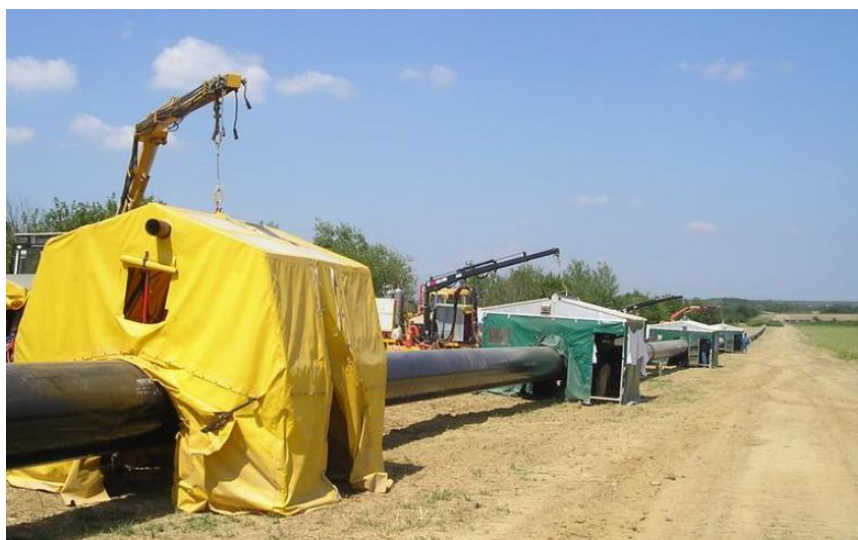
Slika 7.8 Postavljeni zaštitni šatori na trasi radova [33]
