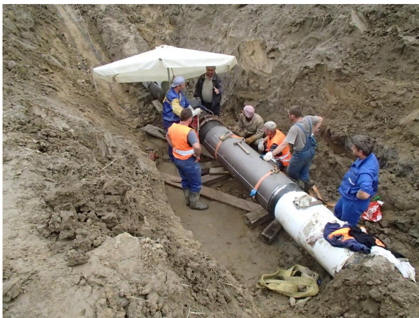
Slika 7.11 Primjer ugradnje čelične obujmice [33]
