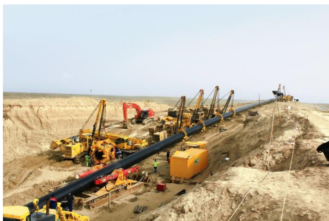
Slika 3.15 Ulaz u horizontalno usmjerenu bušotinu [67]
