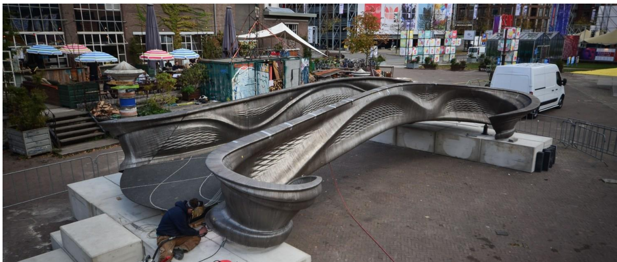
Slika 12. MX3D - most dobiven WAAM tehnologijom [14]
