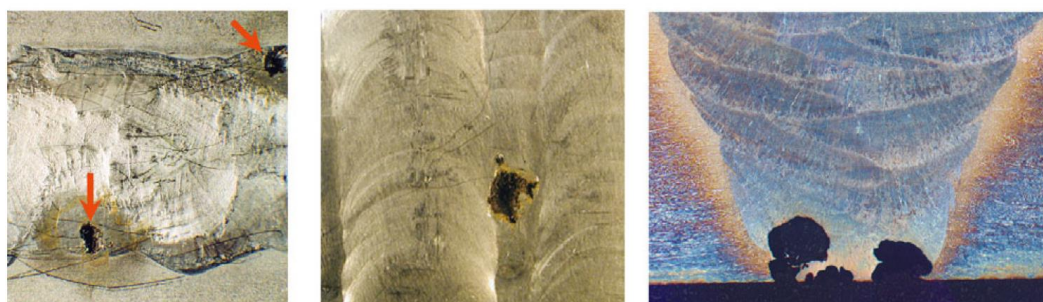
Slika 19. Primjeri rupičaste korozije TIG zavarenog spoja [21]
