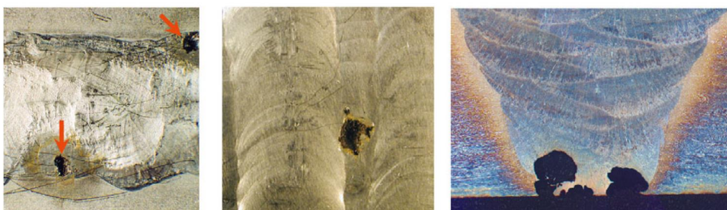
Slika 19. Primjeri rupičaste korozije TIG zavarenog spoja [21]
