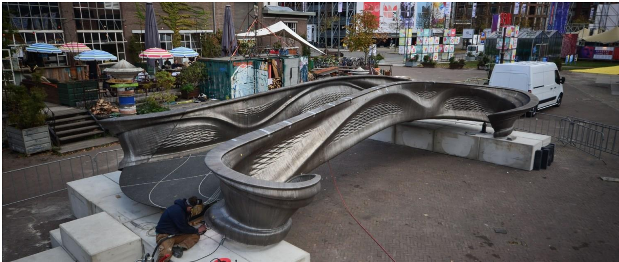
Slika 12. MX3D - most dobiven WAAM tehnologijom [14]
