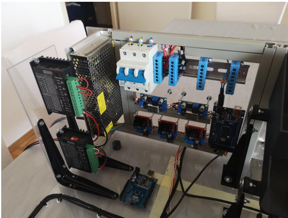
Slika 47. Upravljački ormar pri postavljanju drugog mikrokontrolera
