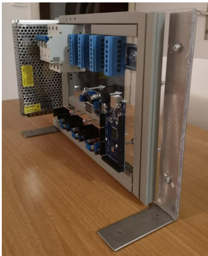
Slika 46. Upravljački ormar u procesu postavljanja komponenti
