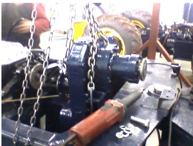
Slika 81: Motaža razvodnika pogona
