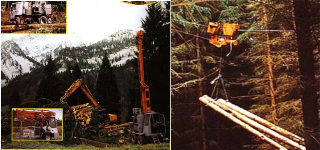
Slika 10: Montažno postrojenje žičare za transport trupaca
