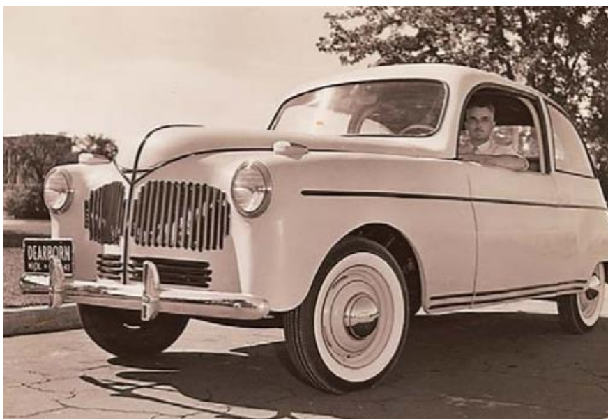
Slika 24. Fordov automobil od duromernog kompozita s konopljom [15]
