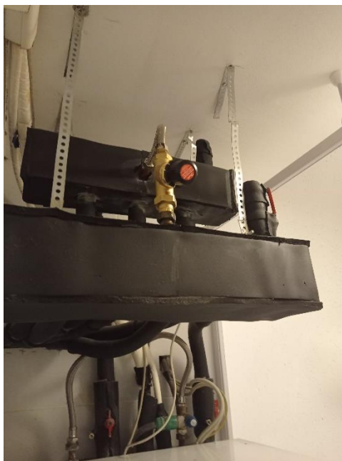
Slika 13. Ventil poslije zamjene
