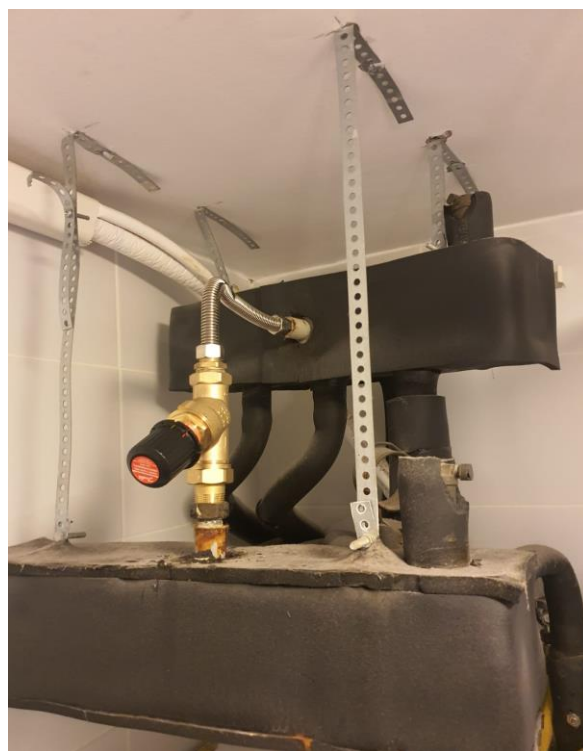
Slika 27. Ventil poslije zamjene
