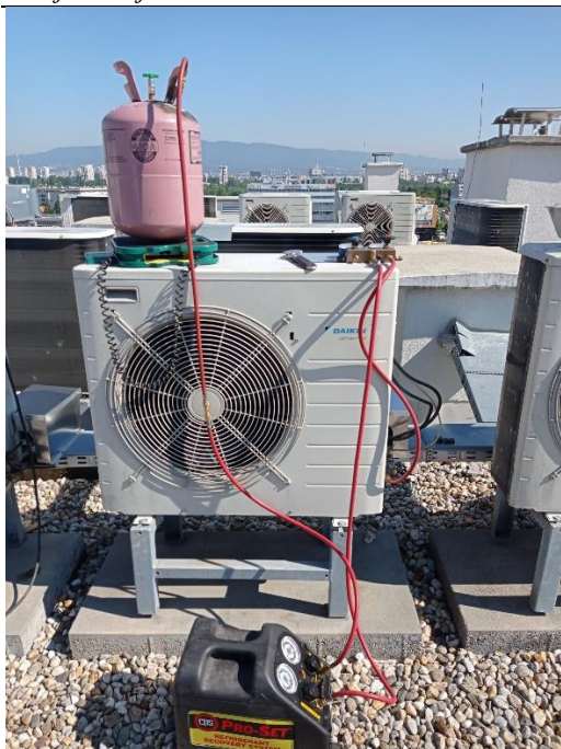
Slika 37. Izvlačenje radne tvari iz sustava
