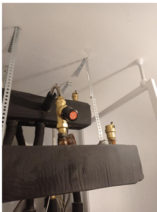
Slika 33. Ventil poslije zamjene
