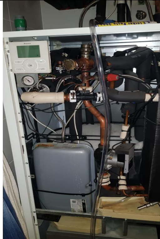
Slika 40. Unutarnja jedinica s elementima
