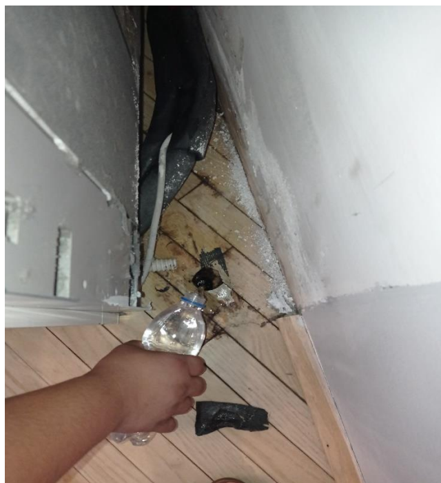
Slika 17. Provjera protočnosti odvoda kondenzata
