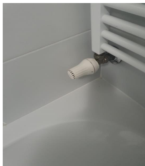
Slika 31. Zamijena novom termostatskom glavom
