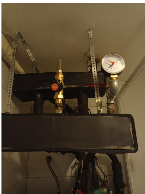
Slika 14. Postavljena tlačna proba
