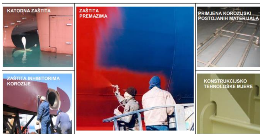
Slika 34. Metode zaštite od korozije [29]
