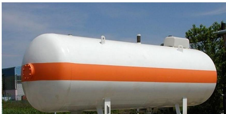
Slika 29. Spremnik za UNP (ukapljeni naftni plin) [26]
