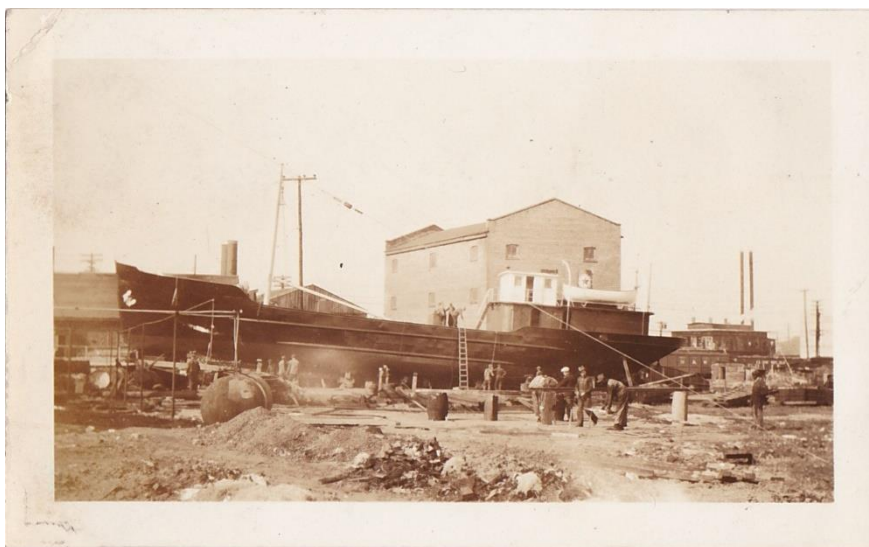
Slika 6. MS Carolinian, prvi komercijalni kompletno zavaren brod [5]
