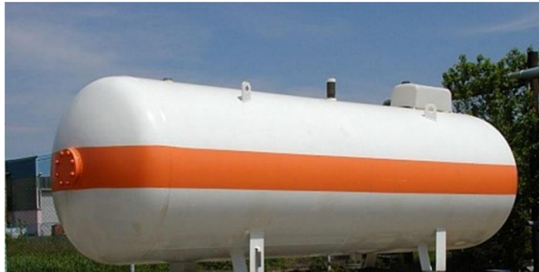
Slika 29. Spremnik za UNP (ukapljeni naftni plin) [26]
