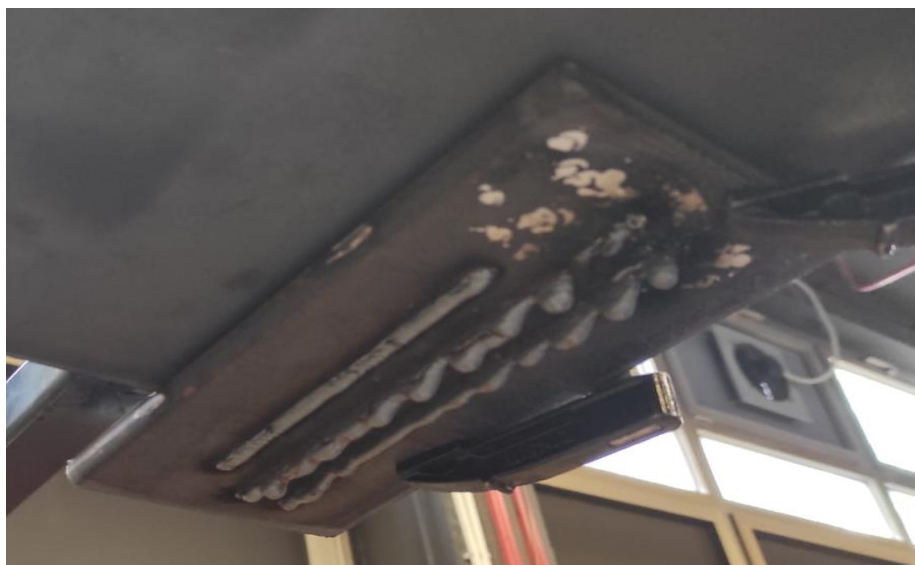
Slika 45. Zidovi izrađeni s njihanjem pištolja za zavarivanje
