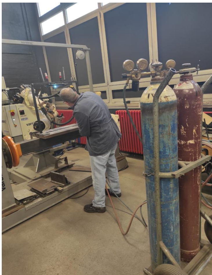
Slika 47. Predgrijavanje podloge i zida
