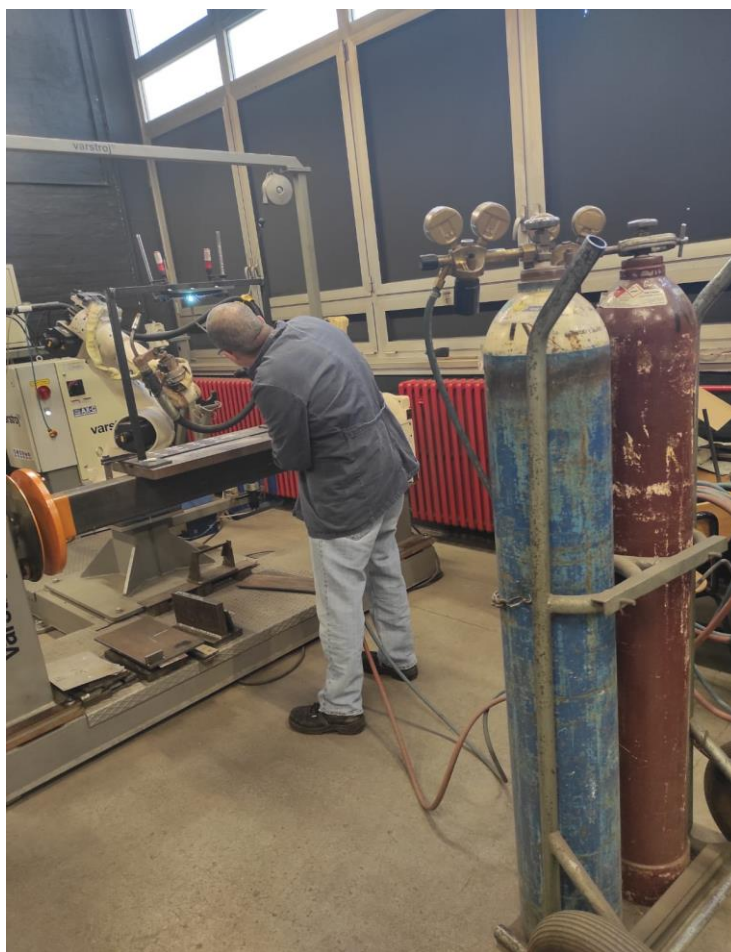
Slika 47. Predgrijavanje podloge i zida
