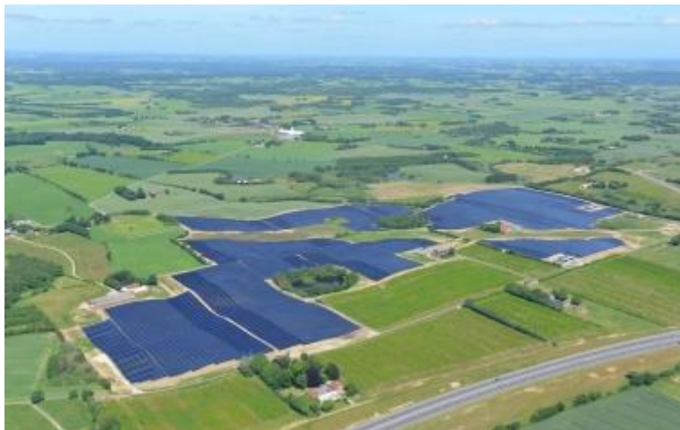
Slika 12. Polje solarnih kolektora u Silkeborgu [21]
